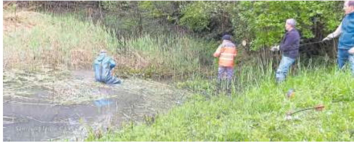
Schilf schneiden mit Unterwasser-Motorsense.
