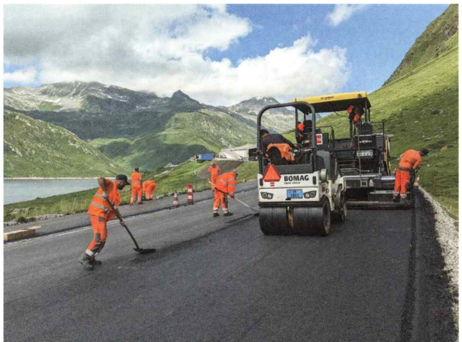
Empa-Teststrecke Lukmanierpass: Einige Schichten enthalten bis zu 85 Prozent Recycling-Asphalt. Foto: Empa
